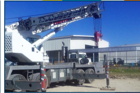
Grúa autotransportable de 75 tn. (1)
